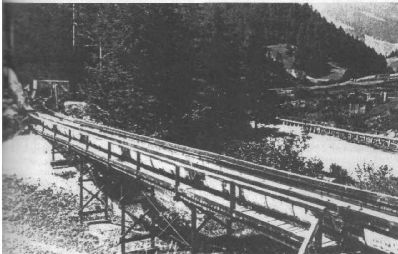
Fig. 12.4 Сплавной лоток Шаубергера повторяет контуры долины
