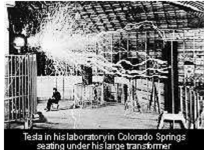
Когда искровой промежуток находится в проводящем состоянии, конденсатор и первичная катушка связаны последовательно, таким образом формируя RLC цепь, в которой произведены электрические колебания определенной частоты. Во вторичной катушке, которая также формирует другую RLC цепь, также производятся электрические колебания из-за индукции напряжения. Частоты колебания обоих цепей определены их структурными параметрами.
